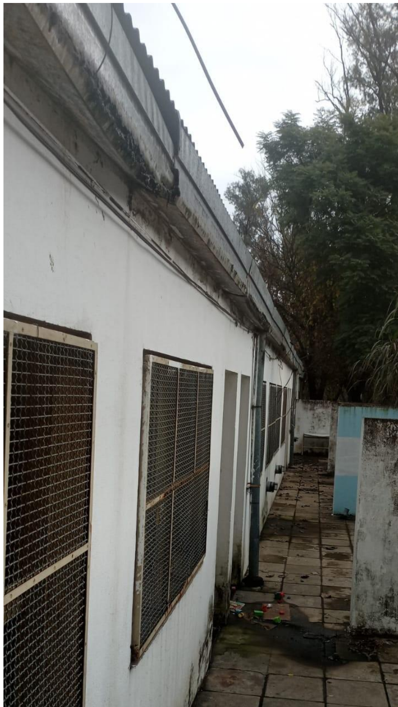
Se observa patio de aulas y canaleta a extraer.
